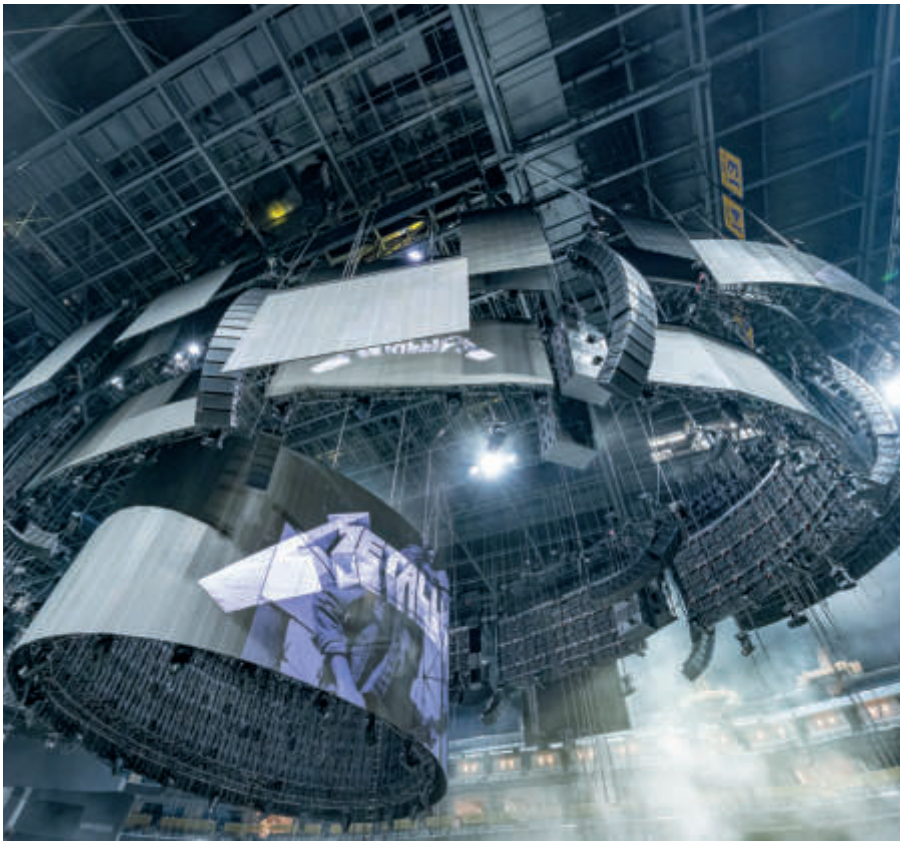
2.890 LED Tiles wurden für insgesamt 45 Flächen verbaut
